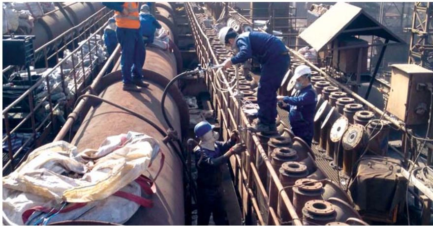
شکل ۳. بارگذاری کاتالیست‌ها در مدول یک فولاد خوزستان (اسفند ۱۳۹۵)
